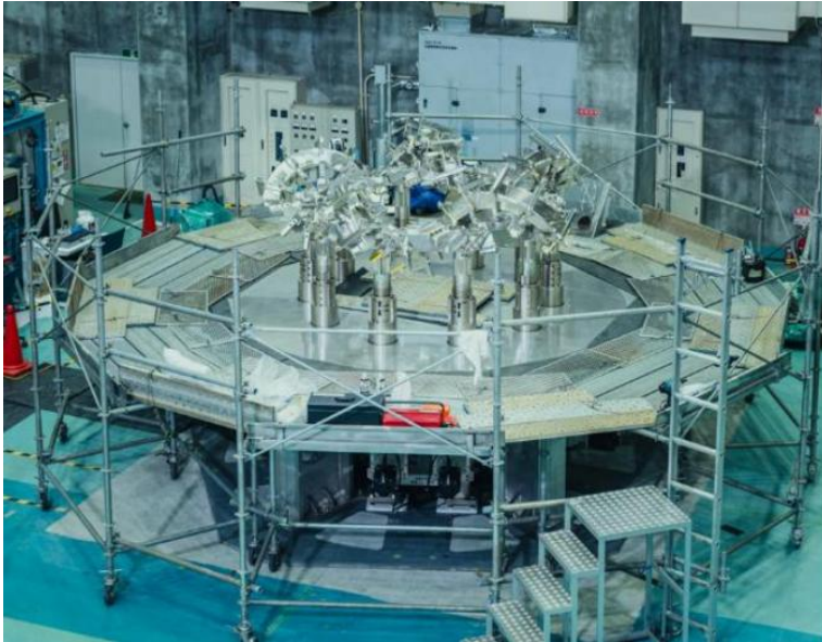
ヘリカルフュージョンが建設中の Helix HARUKA のイメージ（左、作業用の足場に囲まれた中心部が本体）と 同社が 2030 年代に「実用発電」を計画する発電初号機「Helix KANATA」のイメージ（右）
